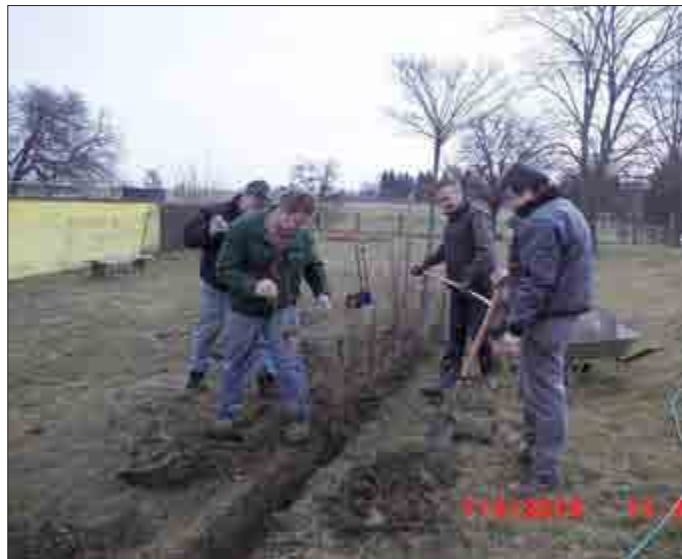
Arbeiten im Schwimmbad
