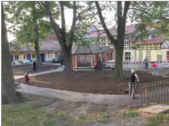
Die Feinarbeiten wurden von Hand gemacht.
