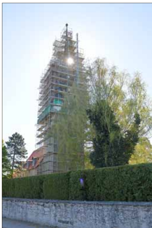
Blick aus der Oberen Kirchstraße (Westseite)
