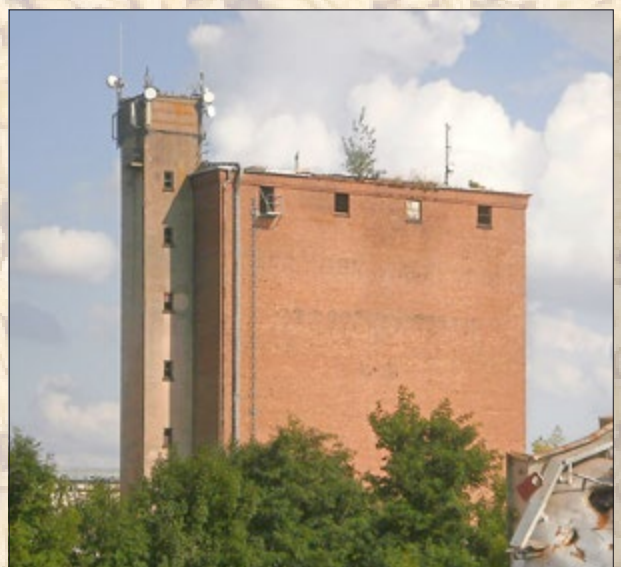
09.05.2010 Getreidesilo mit Turm blieb noch nach dem Abriss erhalten
