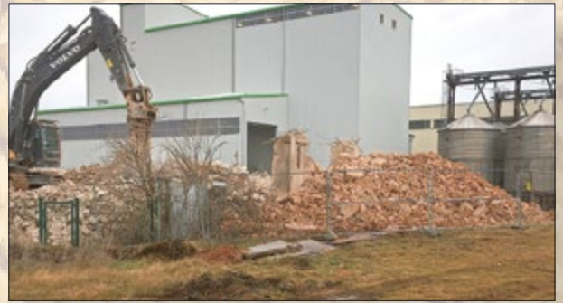
13.01.2021 Letzter Rest der Außenmauer
