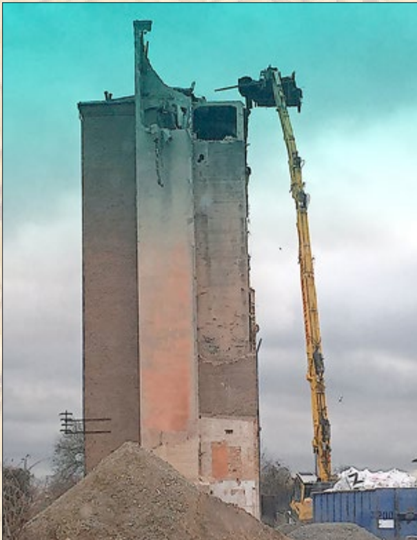
07.12.2020 Beginn der Abrissarbeiten des Malzsilos mit Turm
