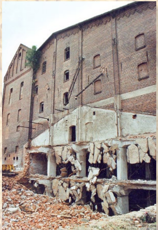
30.07.2007 Beginn der Abrissarbeiten am Gebäude
