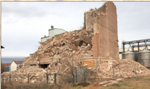
27.12.2020 Letzte Außenwand des Getreidesilos, aufgenommen von der Bahnseite
