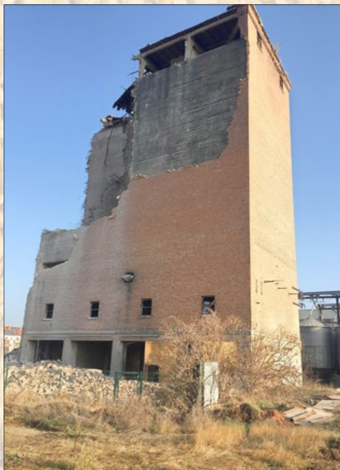
08.12.2020 Abriss des Malzsilos
