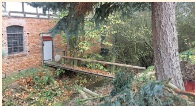
2023 Klippmühle Erneuerung Brücke/Steg
