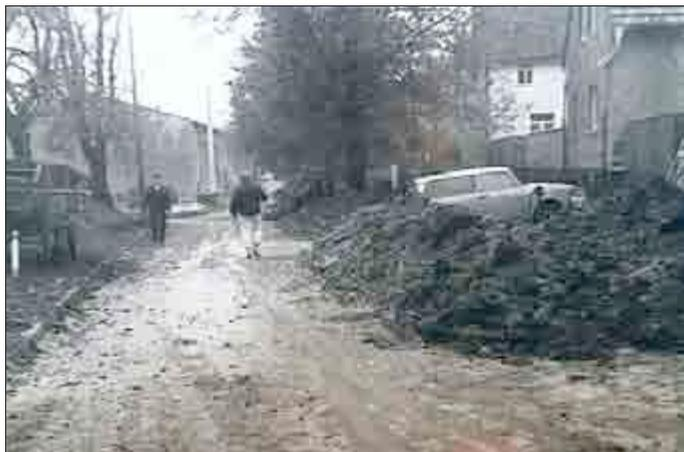
So wurden in der Kirchgasse die ersten 150 m 110er PE-Rohr verlegt und gezeigt, wie man dieses Material verarbeitet. Geholfen haben uns damals 2 Mitarbeiter des WAB Bad Langensalza. Die Langlebigkeit des Materials ist davon abhängig, dass in das relativ weiche Gefüge über Steine und ähnliches keine Riefen reingezogen werden und eine sorgfältige Bettung in steinfreien Sand erfolgt. 0,15 - 0,20 m drunter und 0,25 - 0,3 m über Rohrscheitel.
