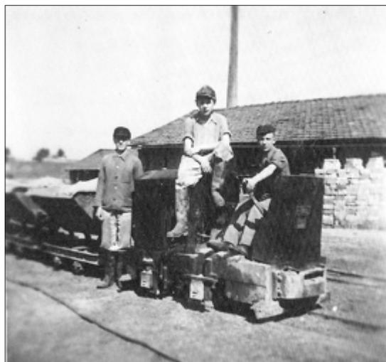
Abb. 1 1954, Zug aus der Lehmgrube, Loren mit Lehm beladen werden zur Weiterverarbeitung des abgebaggerten Materials zu den Gruben zum Einschwämmen gebracht, auf der Lok Dieter Schön, Lothar Ehmsam, hinten ein Trockenschuppen und der Schornstein vom Ringofen (1948 abgebrannt).
